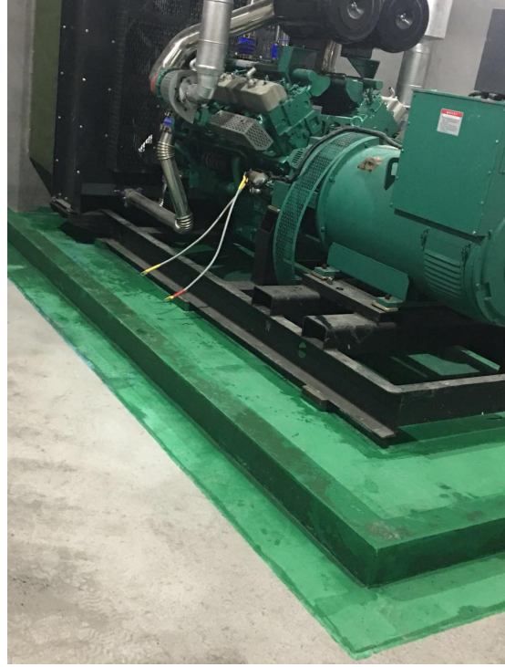
发电机基础防渗（防止污染地下水）
